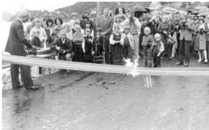
14. august 1982: Opning av vegen til Tafford. Avisahadde ferie då vegen vart opna, men i første utgåve etter ferien var det bilde frå opninga, som skjedde 1. juli ved statsråd Vidkun Hveding. 30. oktober året før var det gjennomslag i tuinnelen.
