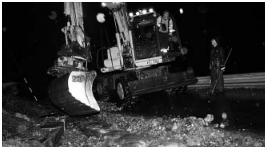
Det måtte gravast ei større grøft langs Hovslia for å leie vatnet unna. Grave-maskina frå Busengdal tok grovarbeidet. (Foto: Kenneth Strømsøy.)
